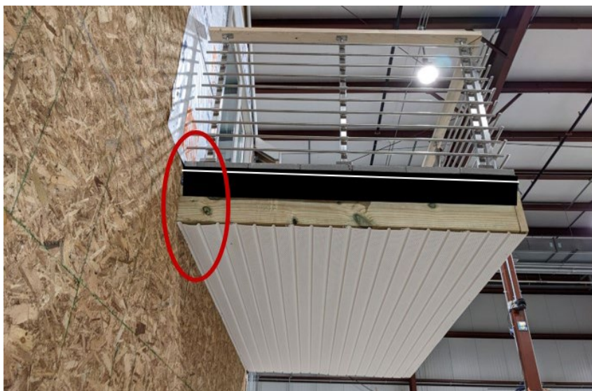
Figura 77. Inspeccionar la Intersección entre el Muro y los Miembros de la Estructura
