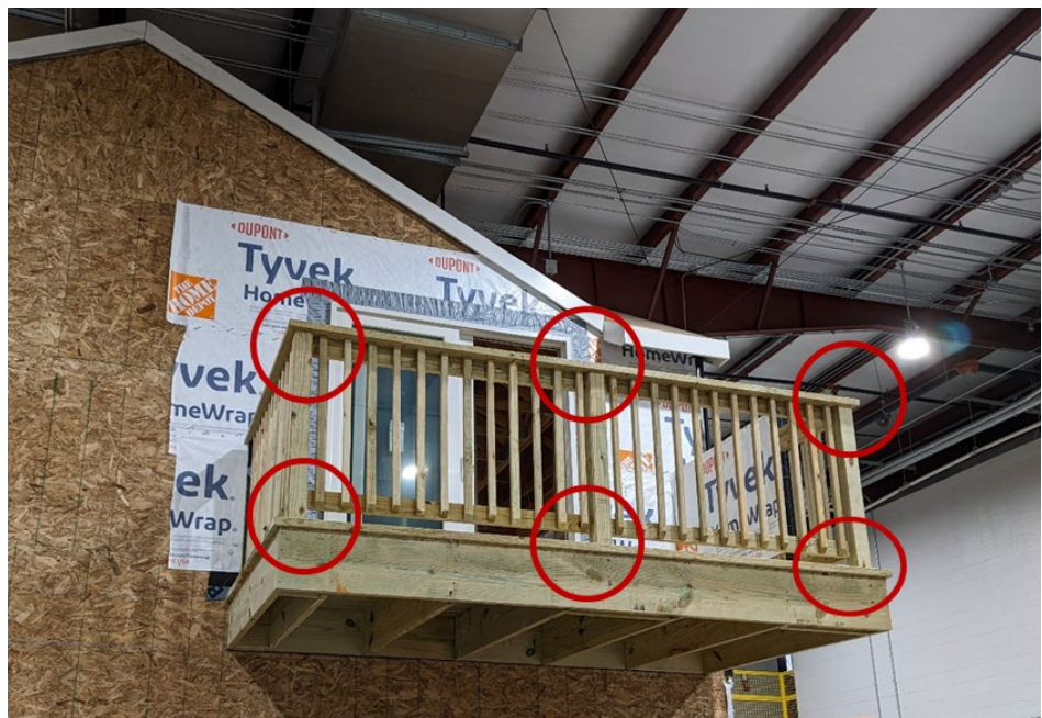
Figura 81. Inspeccionar Todos los Componentes de Madera
