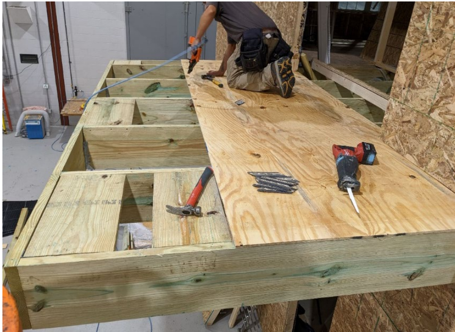
Figura 49. Estructura en Voladizo y Revestimiento de Madera Contrachapada
