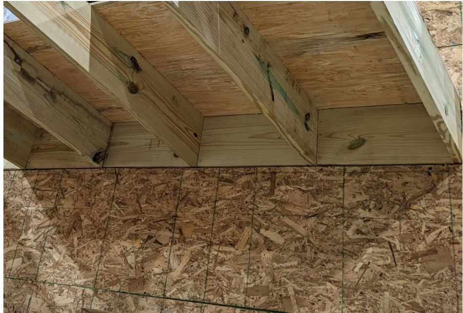
Figura 51. Calafatear y Tapajuntas en la Intersección del Muro
