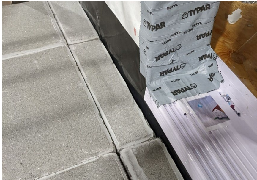
Figura 62. Instalar Cubrejuntas Antepecho al Umbral
