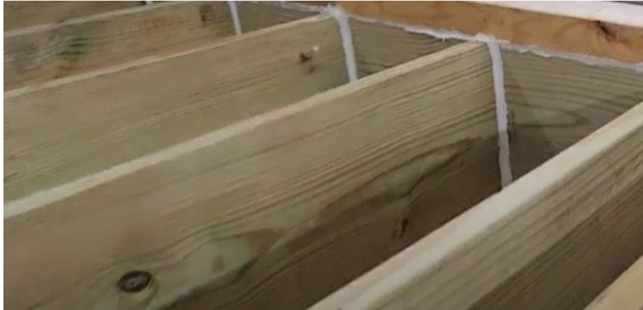
Figura 67. Calafatear el Área de Intersección
