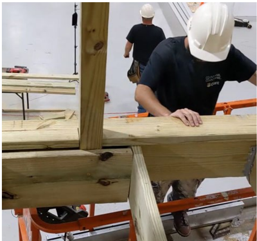
Figura 66. Anclaje del Poste de Madera en la Subestructura
