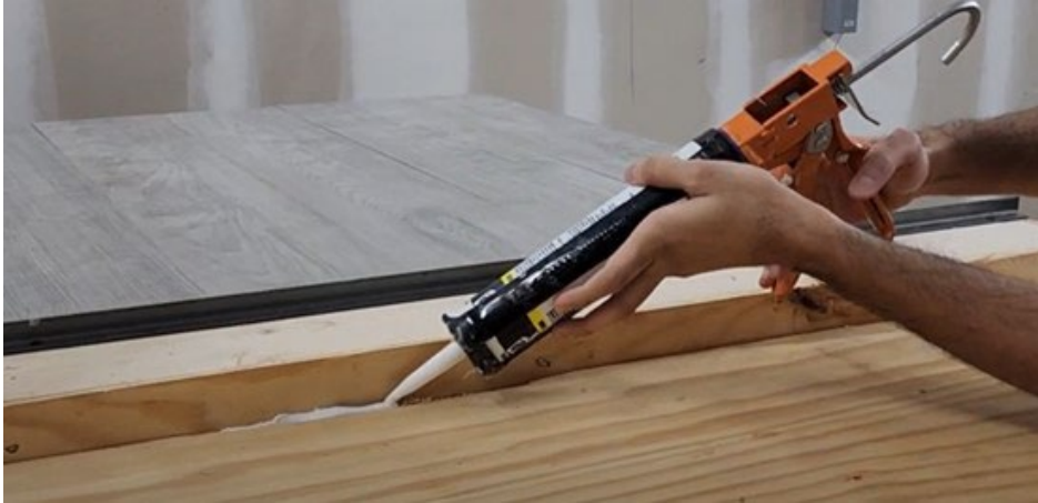
Figura 53. Calafatear en la Intersección de la Infraestructura y el Muro
