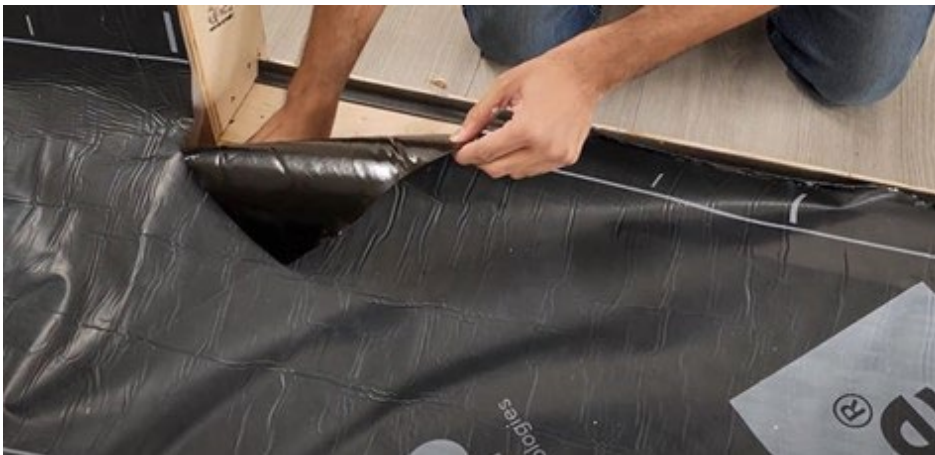
Figura 54. Instalar Membrana Impermeabilizante
