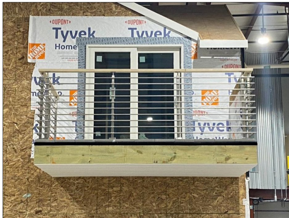
Figura 65. Maqueta Instalada con Superficie de Albañilería
