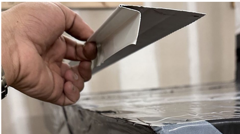
Figura 59. Instalar el Borde de Goteo
