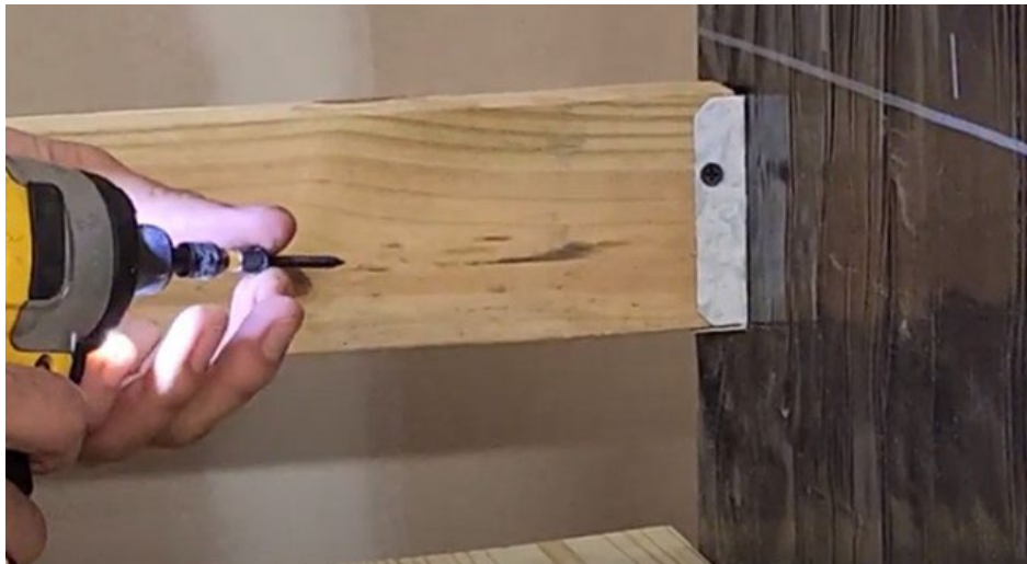
Figura 73. Instalar el Riel de Madera
