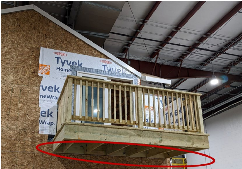
Figura 83. Inspeccionar la Subestructura Abierta
