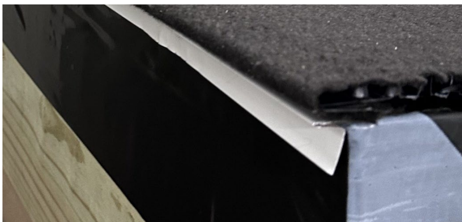
Figura 60. Instalar la Alfombrilla de Drenaje
