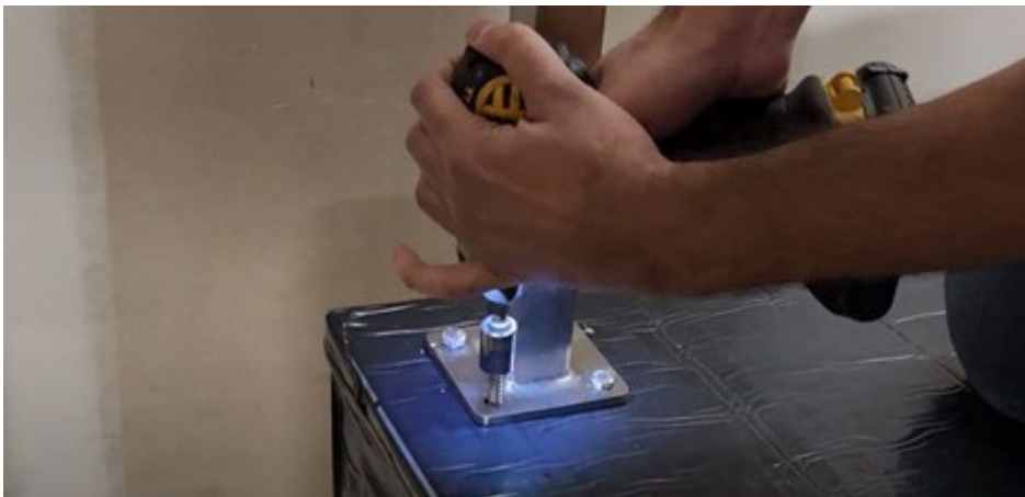
Figura 55. Instalar Poste de Barandal Metálico
