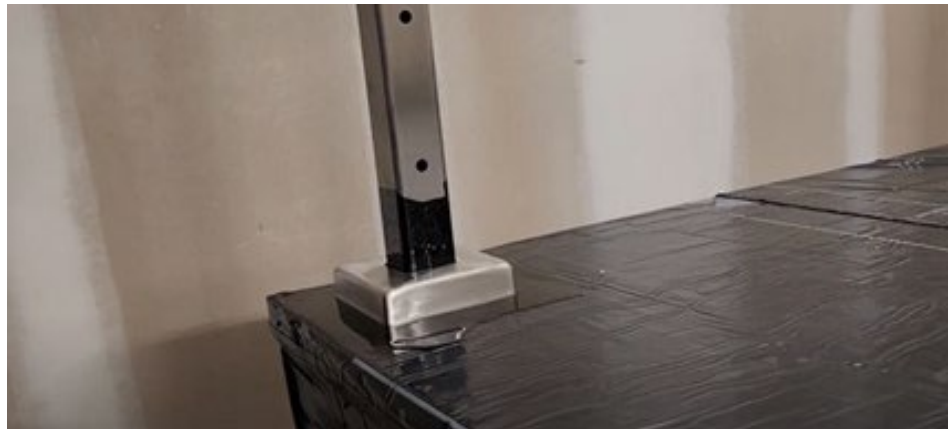
Figura 57. Instalar el Poste de la Cubierta de Riel
