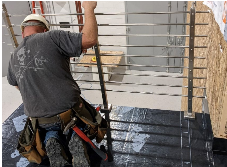
Figura 58. Instalar el Sistema de Barandillas de Metal
