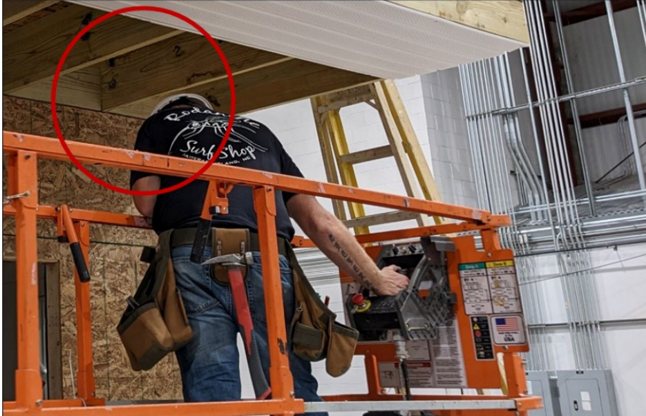
Figura 82. Retire el Recinto e Inspeccione la Subestructura
