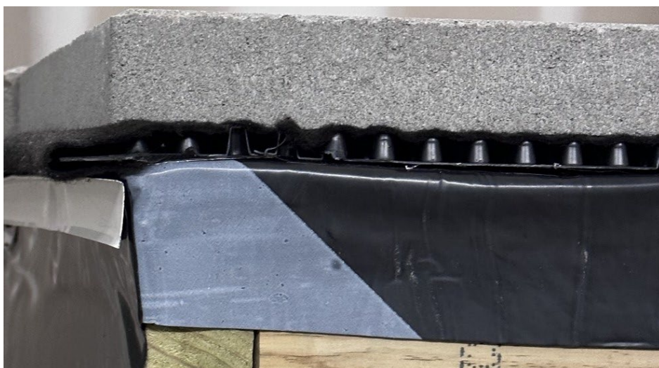
Figura 61. Instalar la Superficie de Albañilería
