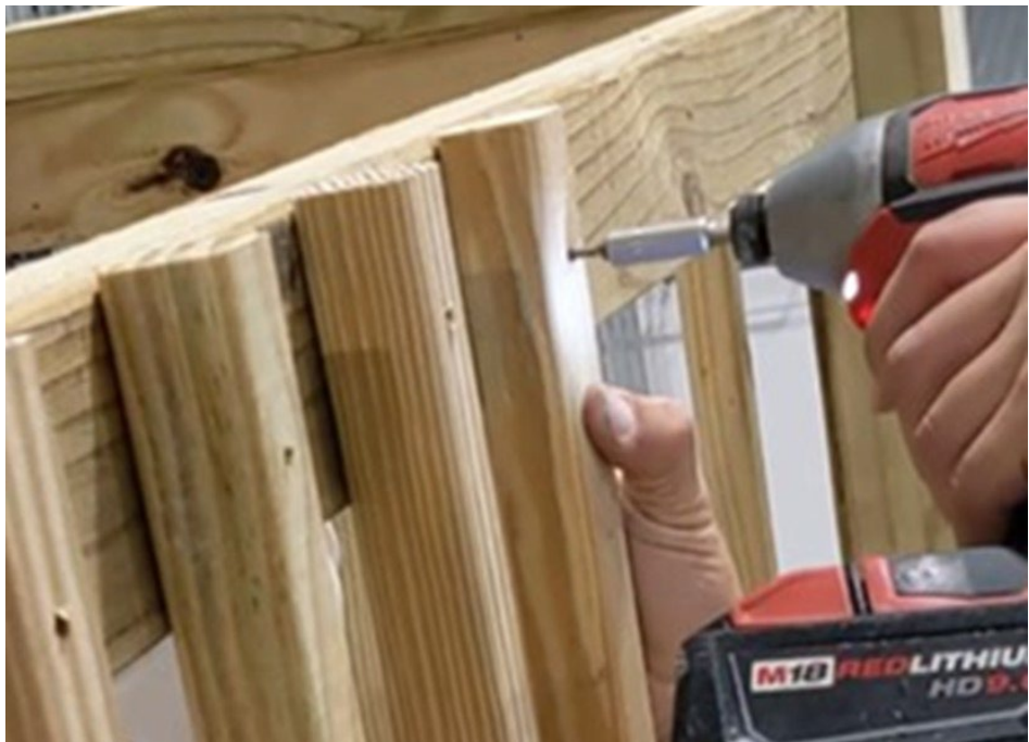
Figura 75. Instalar los Husillos del Sistema de Barandillas
