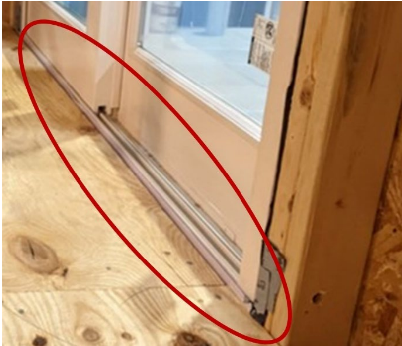
Figura 78. Inspeccionar el Umbral Interior de la Puerta
