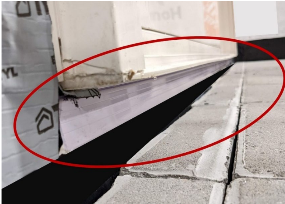
Figura 79. Inspeccionar el Umbral Exterior de la Puerta
