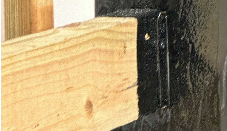
Figura 74. Sellar con Cubrejuntas Aplicada por Líquida
