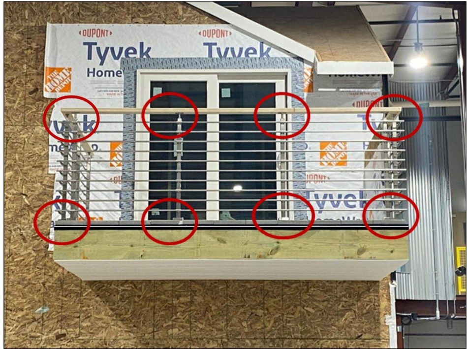
Figura 80. Inspeccionar Todos los Componentes Metálicas
