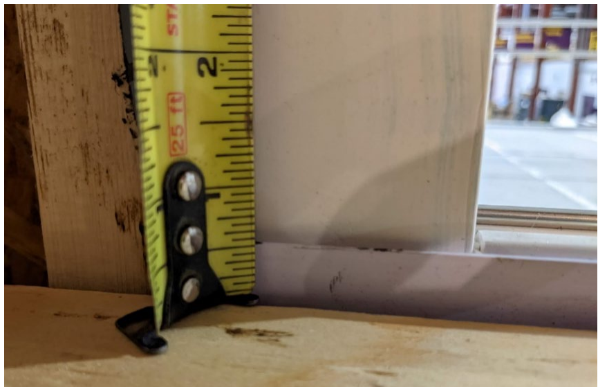
Figura 63. Medar la Altura en el Umbral para Accesibilidad
